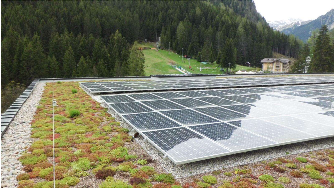
Figura 9 - Tetto verde Piscina coperta di Canizei – 1450 m.s.l.m.
