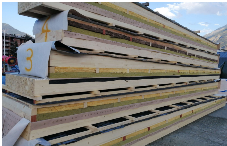
Figura 8 - Componenti prefabbricate in legno tipo balloon-frame
